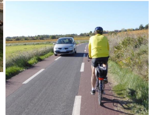
Figure 36 – Exemples de chaussée à voie centrale banalisée en milieu rural (sources : Ingetec et Cerema)
