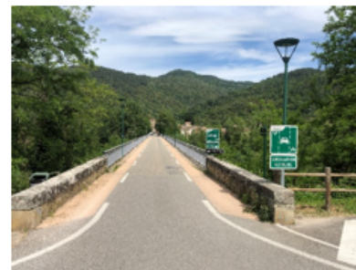
Exemple d'une CVCB sur un pont, Saint-Fortunat-sur-Eyrieux, Ardèche
