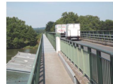
Exemple d'encorbellement, dans le Lot
