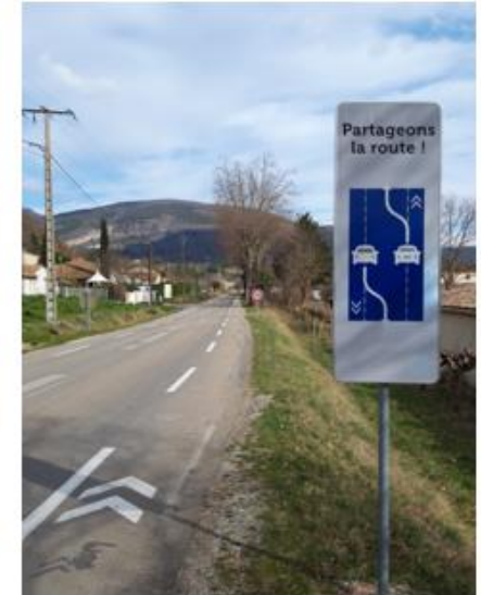
Exemple d'une CVCB sur une route départementale, Saillans
