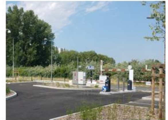
Exemple de parking avec barrière automatique
