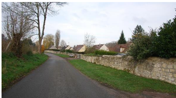
Mur ancien le long de la rive bâtie, rue du Mesnil
