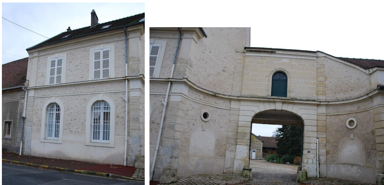
Entrée sud (rue Bamberger)
