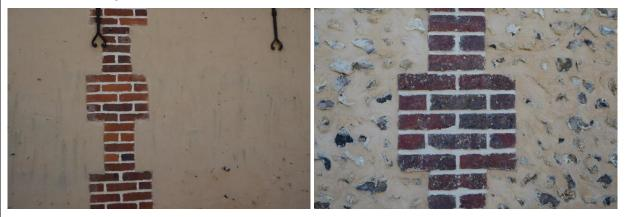
Exemple de réalisation avec soubassement, bandeau d'étage et harpages, constituant un bon modèle pour la réalisation des nouvelles façades (extension de la mairie)
