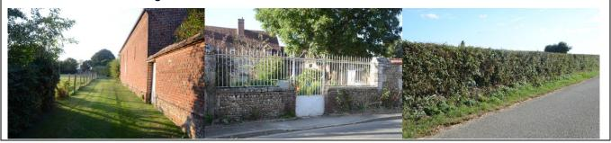
Les murs de clôture devront présenter des rappels en brique rouge en terre cuite (pleine ou de parement) : piliers, chaînage\*, chaperon\*, soubassement\*, harpage\*, ... Les autres parties maçonnées devront être recouvertes d'un enduit avec une finition de type « gratté fin » et une tonalité rappelant les enduits anciens au mortier bâtard ou à la chaux : gamme des ocres / jaunes
