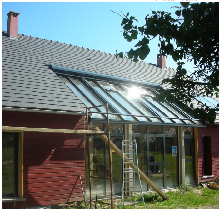
Création d'une verrière dans un volume traditionnel
