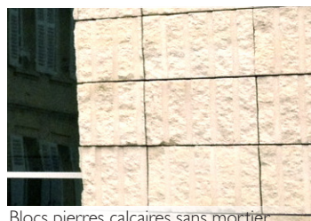
Blocs pierres calcaires sans mortier
