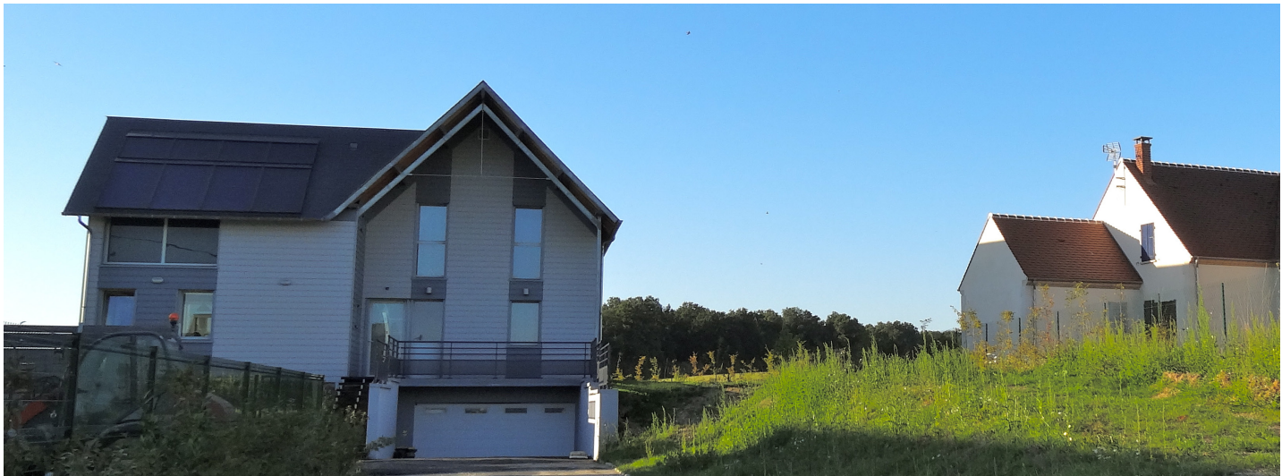
Maison contemporaine reprenant le volume et la forme d'une construction traditionnelle (Fleury)
