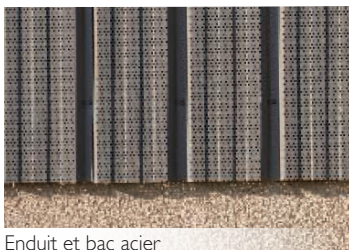
Enduit et bac acier
