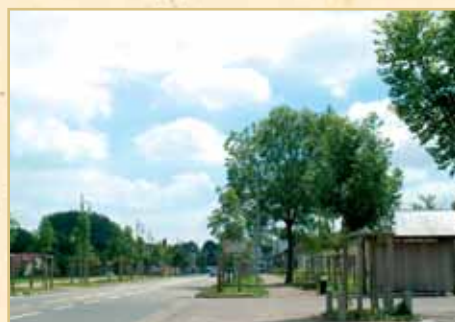
Réalisation d'un projet de traverse d'agglomération
