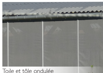
Toile et tôle ondulée
