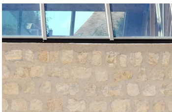
Moellons et vitrage
