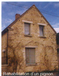
Réhabilitation d'un pignon.
