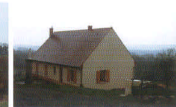
Liancourt-St-Pierre. Le volume de la maison ne respecte pas la vue du site.
