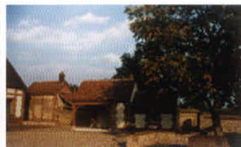
Thivilliers. Annexes réalisées dans les mêmes matériaux que le corps principal.
