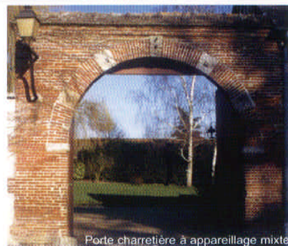
Porte charretière à appareillage mixte.
