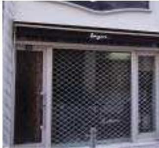
*Les enroulements des grilles sont placés à l'intérieur du magasin, le dispositif est intégré à la devanture. Les coffres à rideaux sont placés dans les tableaux. Les rideaux pleins sont à éviter ou utiliser seulement au droit des accès.*
