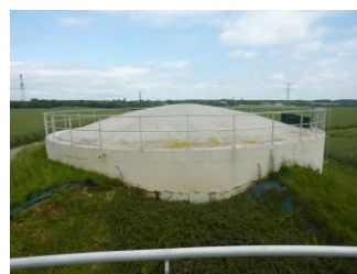
Réservoir d'Andeville (source : SMEPS)
