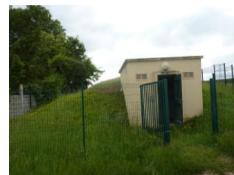
Réservoir et surpresseur de Lalande (source : SMEPS)
