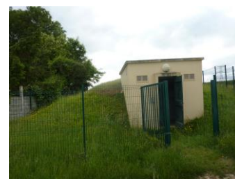
Réservoir et surpresseur de Lalande (source : SMEPS)
