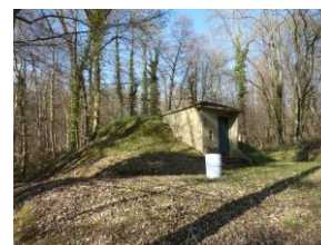
Réservoir de Chavençon (source : SMEPS)
